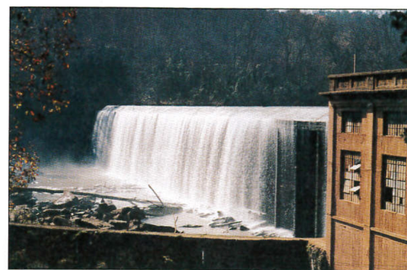
Bartletts Ferry Dam, Georgia, USA.
