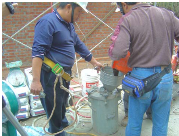
照片 12 將調配完成的複合黏著劑置入低壓灌注機械。
