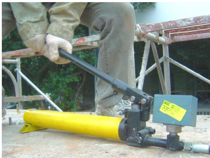
照片 17、照片 18、照片 19 七日強度之拉拔測試。
