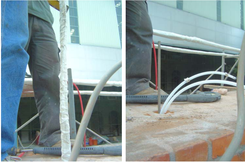
照片 9、照片 10 將不銹鋼拉筋與複合膨脹織布緩緩插入孔洞。
