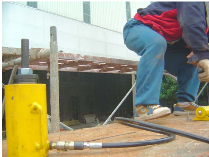
照片 23、照片 24、照片 25 二十八日強度之拉拔測試。
