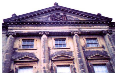
外部上端橫樑區域補強
