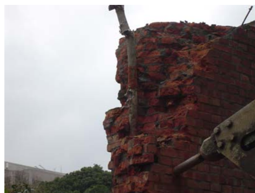
照片 26、照片 27、照片 28、照片 29 將試作磚構造壁體進行拆除。
