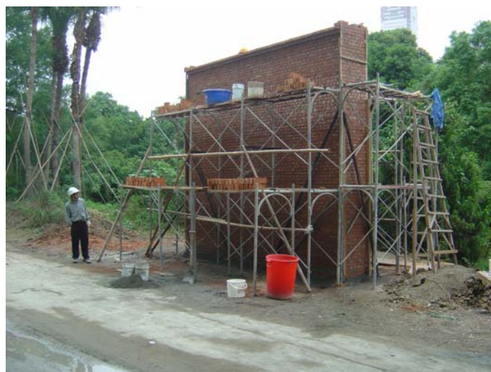
照片 4 新砌之磚構造壁體。
