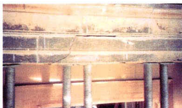
橫樑結構補強-1
