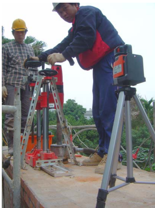
照片 5、照片 6 依據紅外線裝置，架設乾式鑽孔機。
