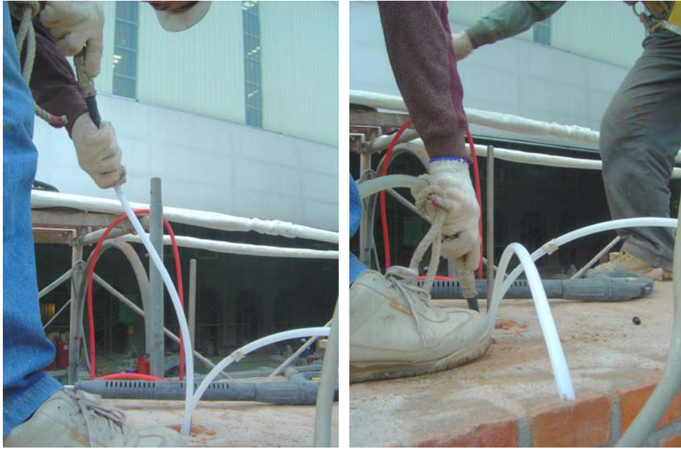
照片 13、照片 14 安裝灌注頭，並開始進行灌注。
