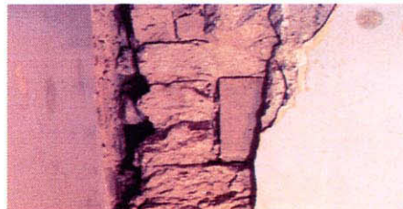
內部木質橫樑區域補強
