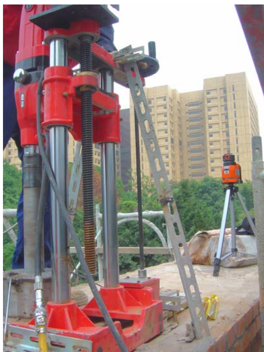
照片 5、照片 6 依據紅外線裝置，架設乾式鑽孔機。
