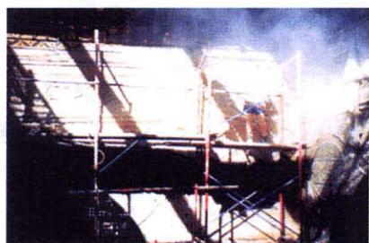
裝飾壁板鑽孔放置鞏固錨栓
