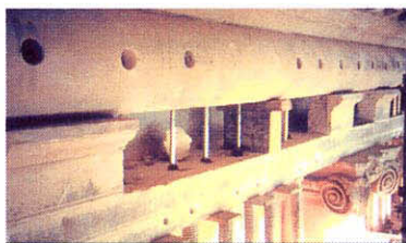
橫樑結構補強-2
