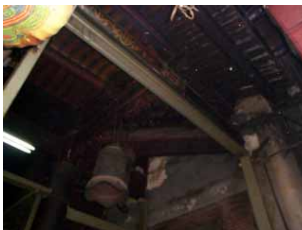
照片 6 樂成宮次間位置木構架與山牆接合部位
