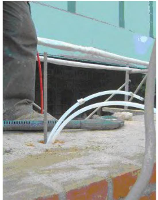
照片9,照片10将不锈钢拉筋与复合膨胀织布缓缓插入孔洞.
