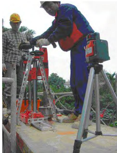
照片5, 照片6 依据红外线装置,架设干式钻孔机.
