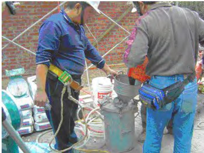
照片12将调配完成的复合粘著剂置入低压灌注机械.
