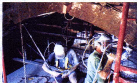
穹隆結構施作
