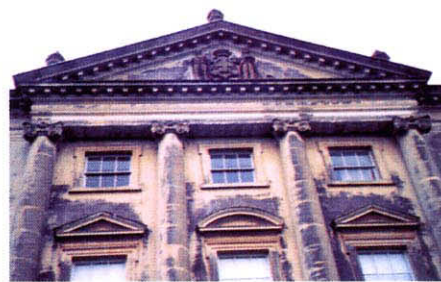
外部上端橫樑區域補強
