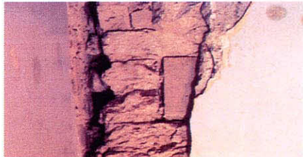
內部木質橫樑區域補強
